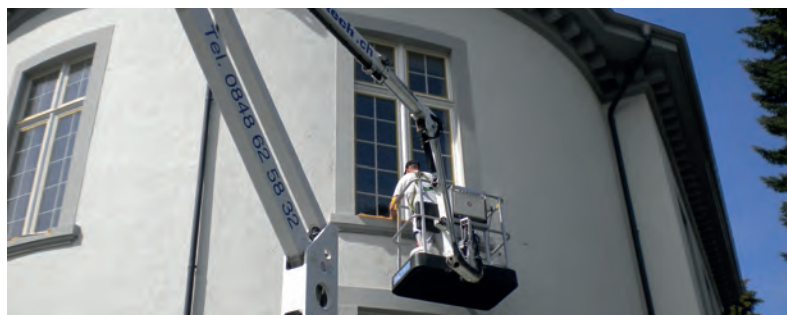
Fensterrenovation an der Kirche
