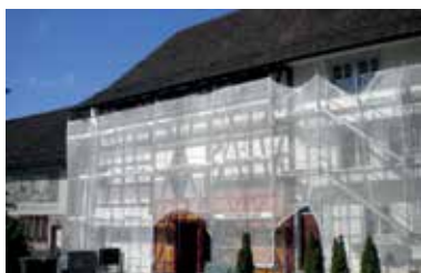
Auffrischung Fassade Kirchgemeindehaus
